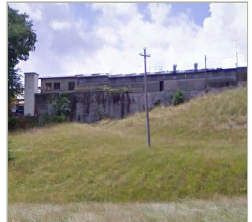
Documentazione fotografica (edificio da demolire, Lato Nord)
