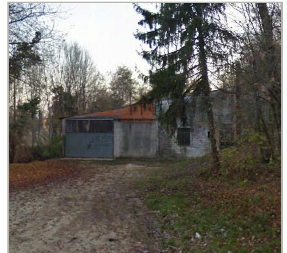
Documentazione fotografica (edificio da demolire, Lato Sud)
