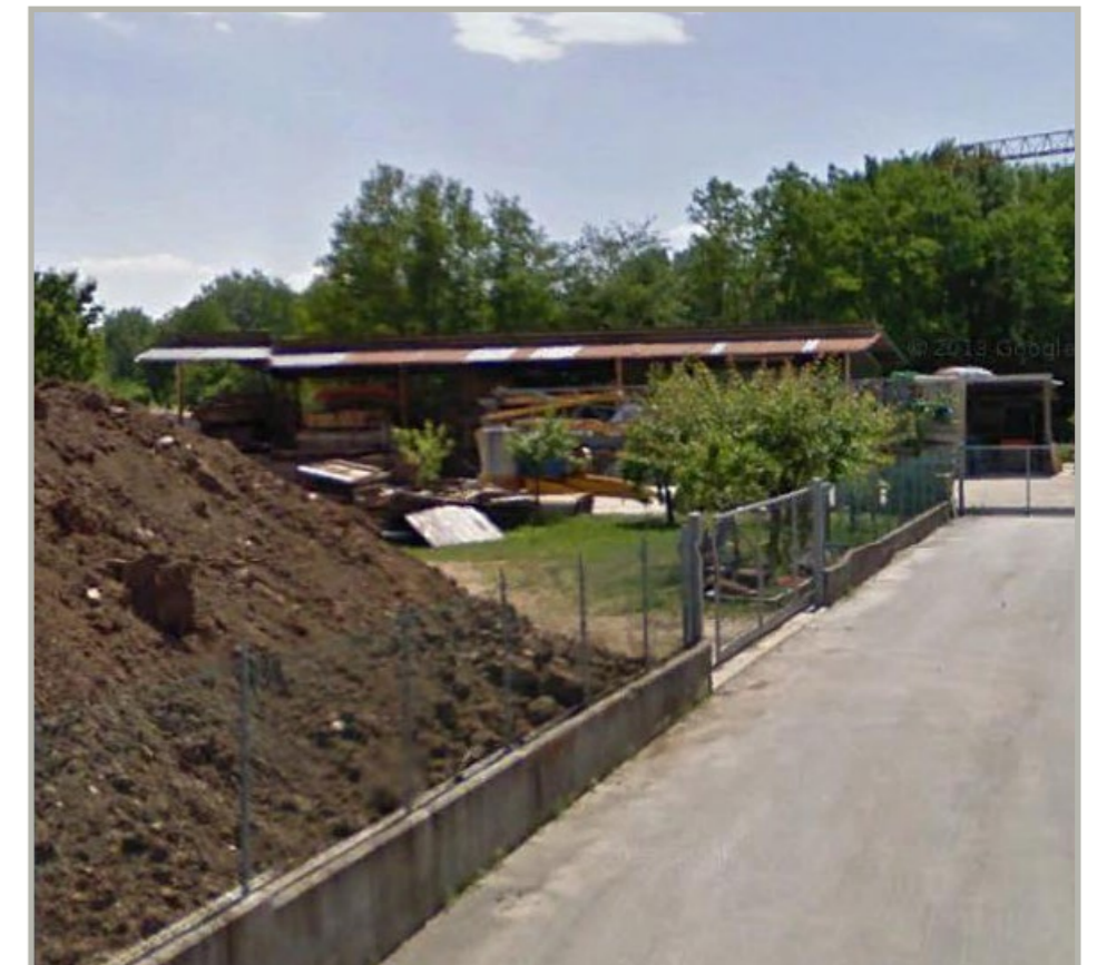
Documentazione fotografica (edificio da demolire, Lato Nord)
